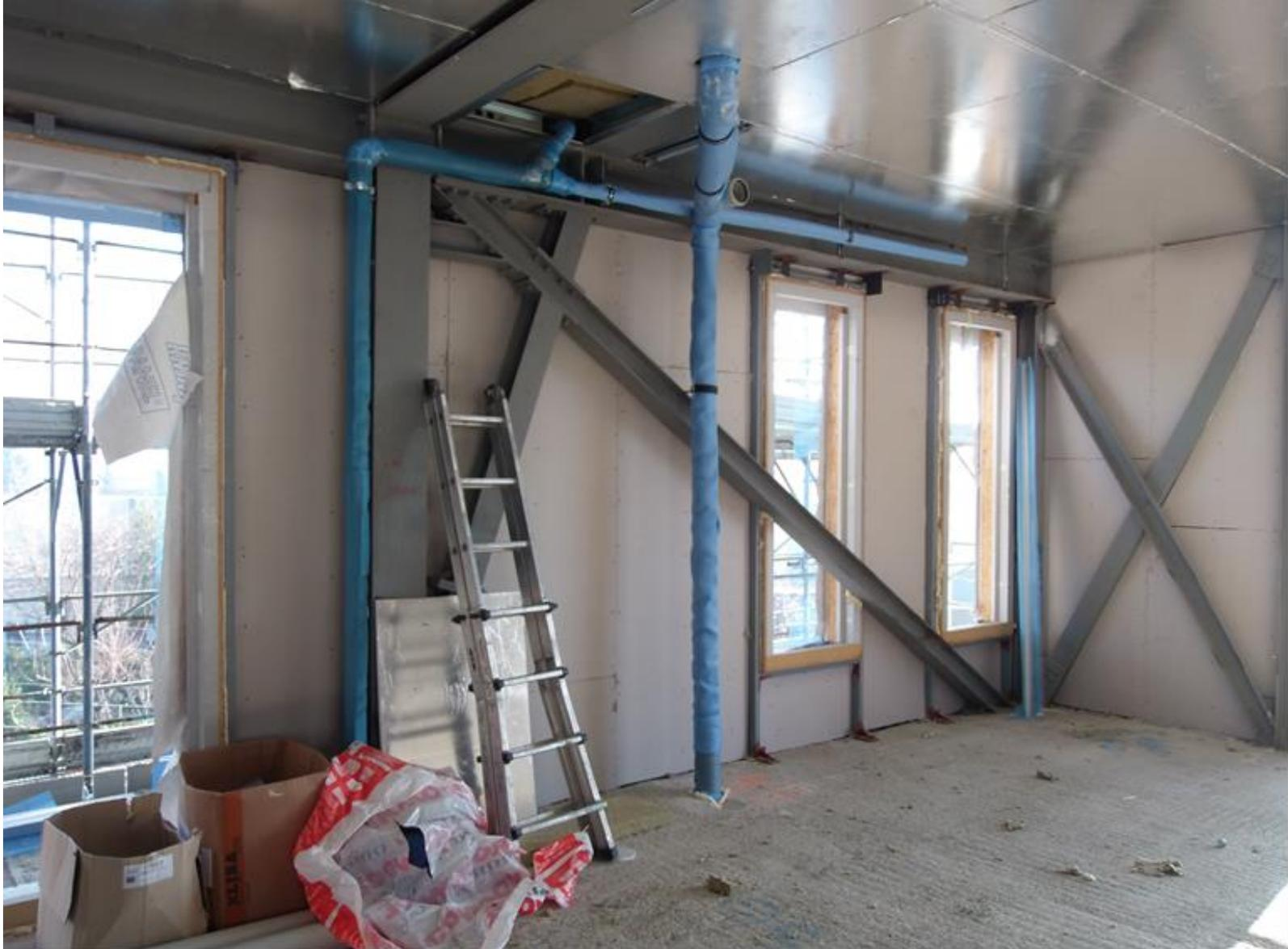
**REALIZZAZIONE DELLE TUBAZIONI DI SCARICO ACQUA BIANCHE E ACQUE NERE PRIMA DEL COMPLETAMENTO DELLE PARETI PERIMETRALI.
