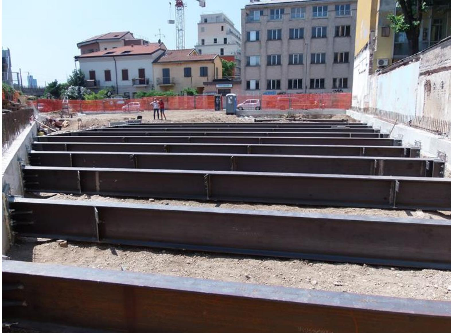
**STRUTTURE IN ACCIAIO A PARTIRE DAL PIANO ZERO: REALIZZAZIONE DI TRAVI ANCORATE DA PARTE A PARTE PER NON AVERE PILASTRI AL PIANO INTERRATO. SI È USATO IL TERRENO COME CASSERO PER LA POSA DELLE TRAVI E POI SI È PROCEDUTO AGLI SCAVI**
