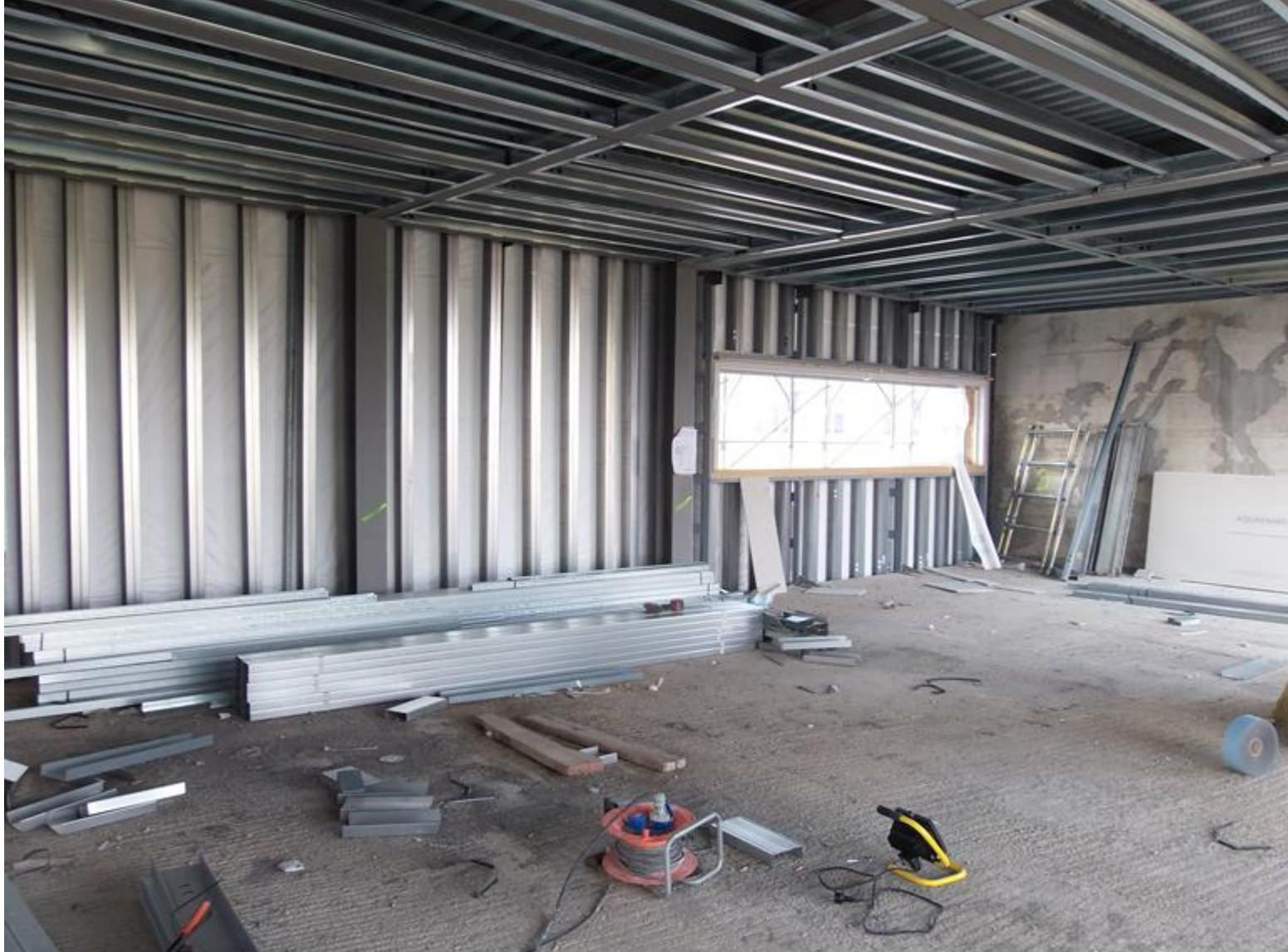
POSA DI TELO TYVEK DI KNAUF DIETRO ALLE LASTRE DI AQUAPANEL DELLA FACCIATA E REALIZZAZIONE DI STRUTTURA PRIMO LIVELLO DI CONTROSOFFITTO ISOLATO
