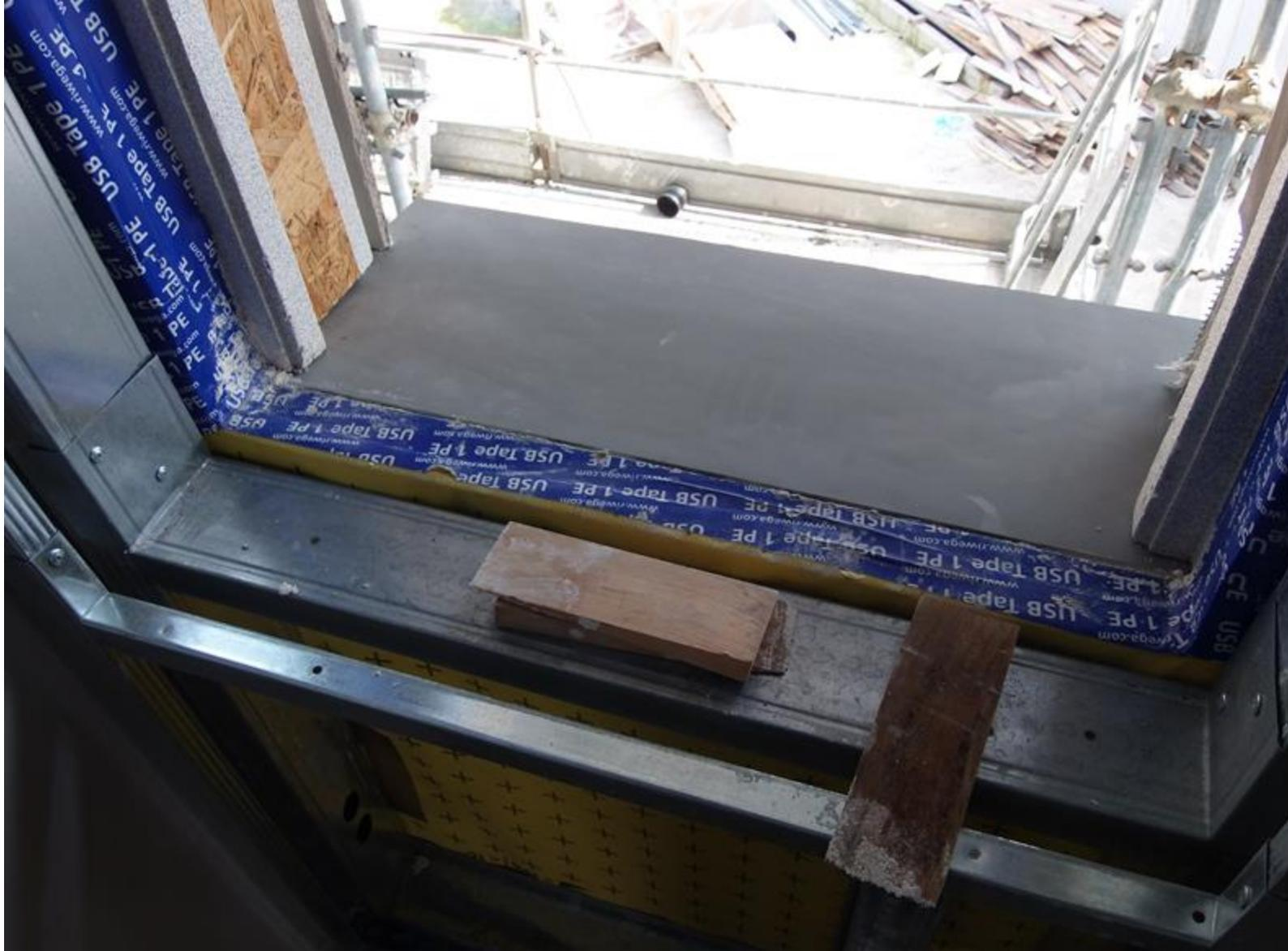
**PARTICOLARE NASTRATURA CON SISTEMA RIWEGA IN CORRISPONDENZA DI SERRAMENTO CON IMBOTTE ISOLATO**
