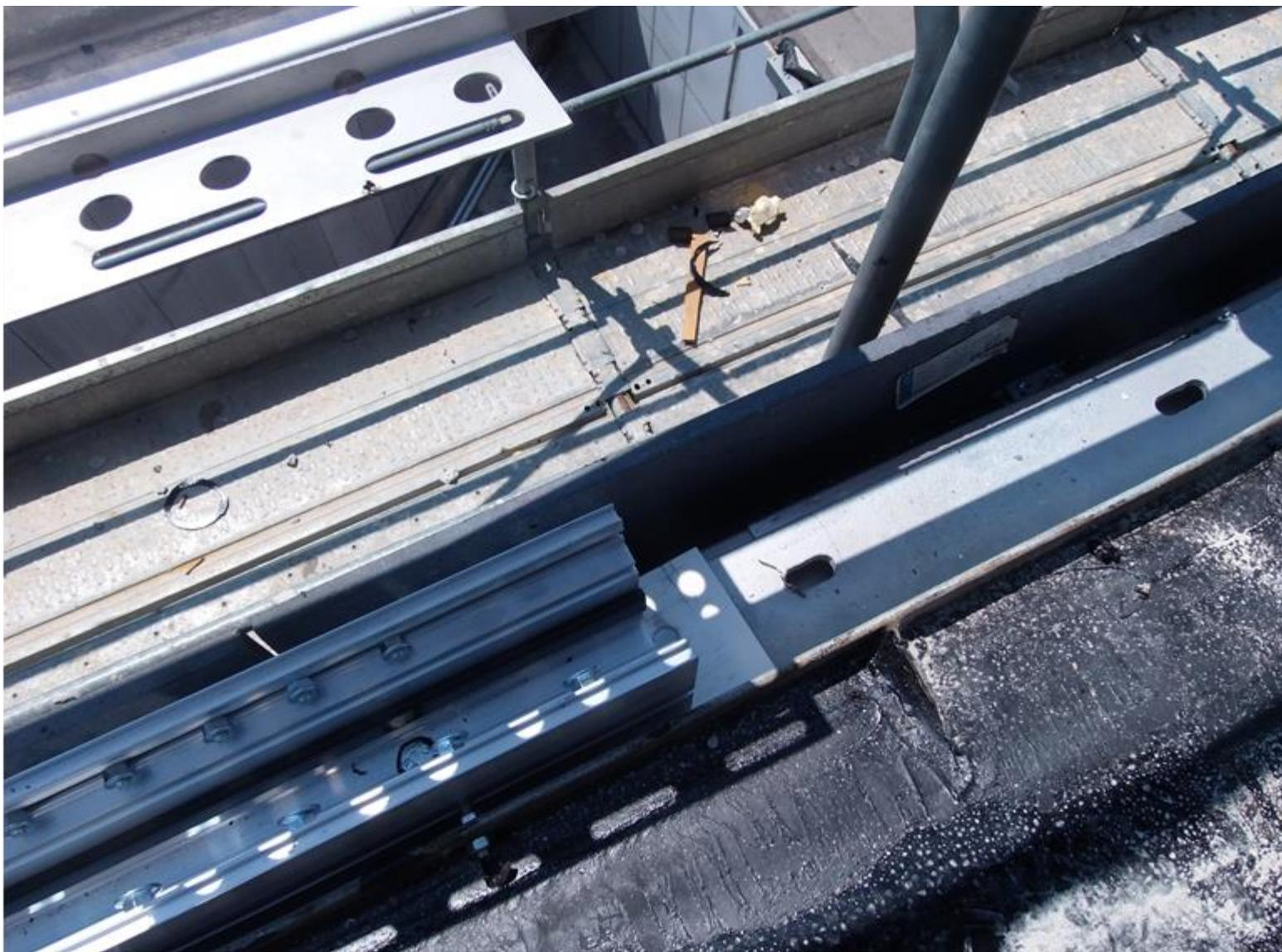
**PARTICOLARE DISGIUNTORE TRA PROFILO DI ALLUMINIO PORTA PARAPETTI E SUPPORTO DI FISSAGGIO IN FERRO**
