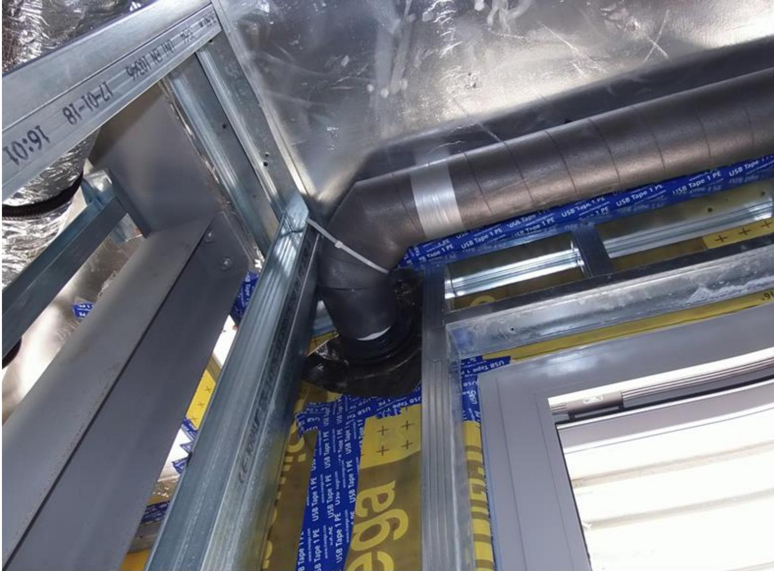
**PARTICOLARE SIGILLATURA A TENUTA ALLA'RIA CON SISTEMA RIWEGA DI ISOLAMENTO ALL'ARIA DEL CONDOTTO DELL'ARIA PRIMARIA**
