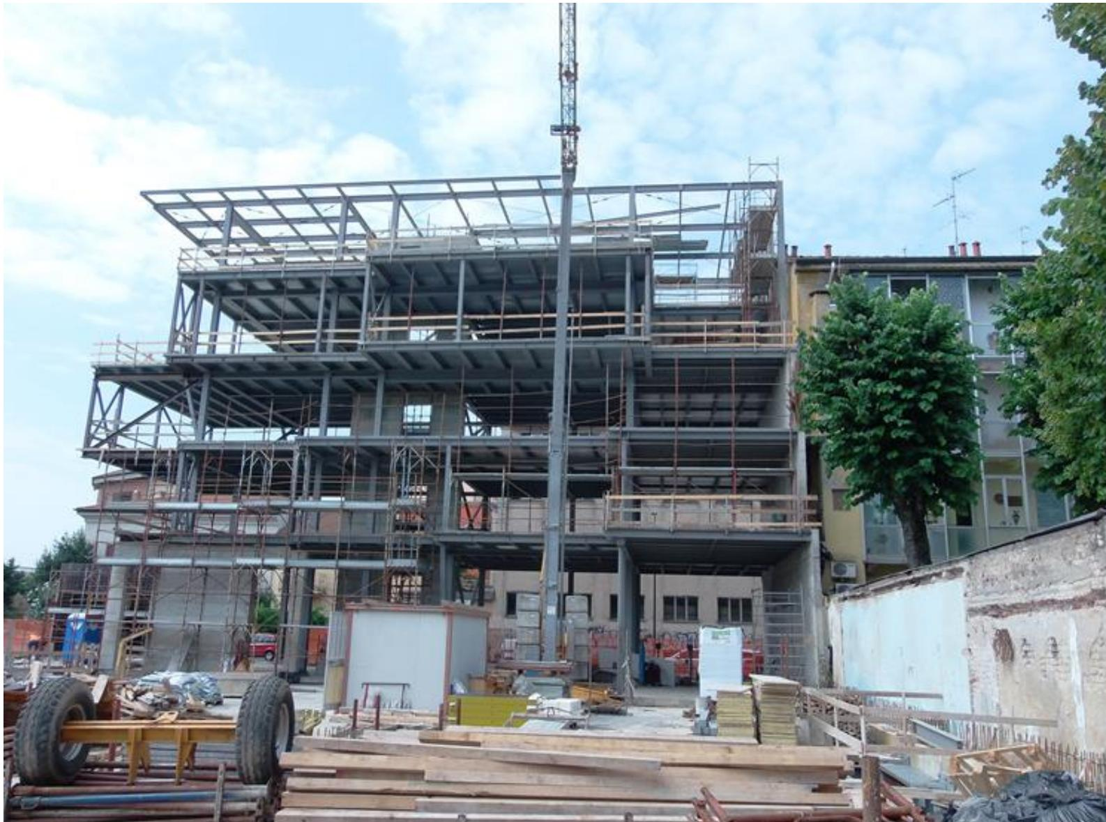
**STRUTTURE IN ACCIAIO CHE HANNO CONSENTITO DI RIDURRE IL NUMERO DI PILASTRI INTERNI E DI CREARE AGGETTI E SOLETTE INTERPIANO SOTTILI IN LAMIERA GRECATA CON GETTO CORROBORANTE DI SOLI 9 CENTIMETRI DI SPESSORE**
