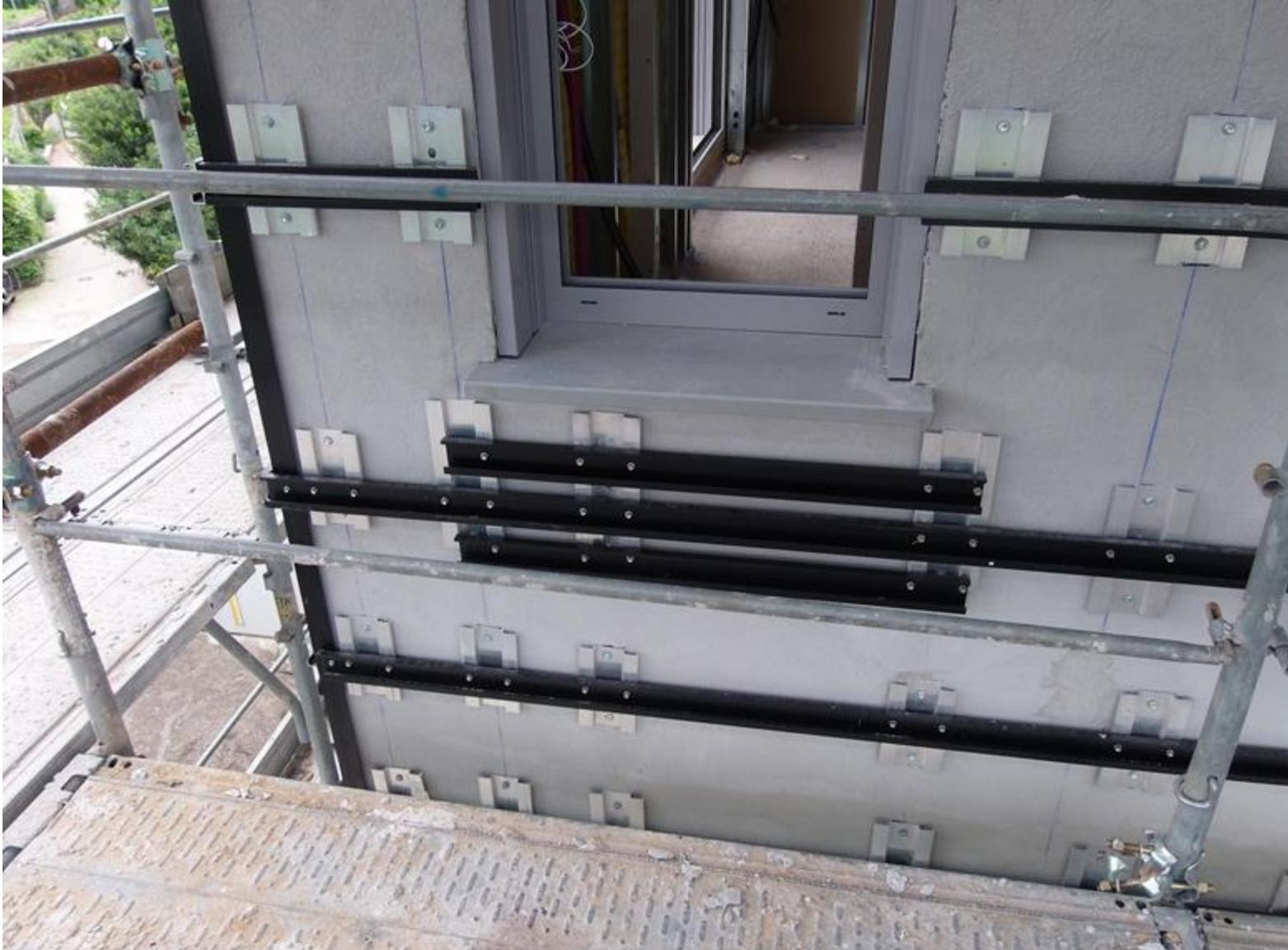
**MONTAGGIO STAFFE A OMEGA E CORRENTI PER FACCIATA VENTILATA DIRETTAMENTE FISSATE ALLA SOTTOSTRUTTURA METALLICA IN FERRO ZINCATO CON VITI CON GUARNIZIONI DI TENUTA ALL'ACQUA**
