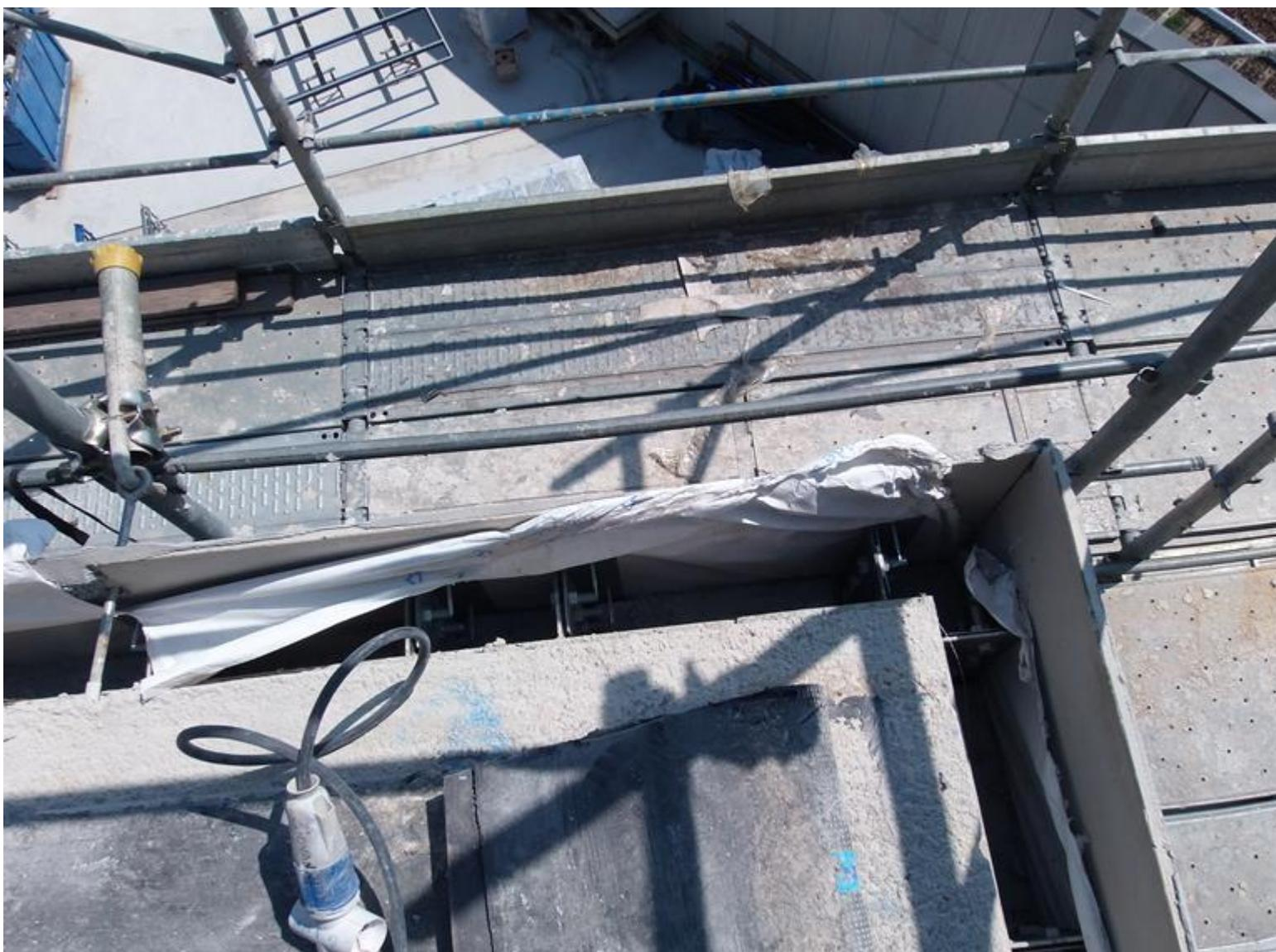
**PARTICOLARE STAFFE DI FISSAGGIO SOTTOSTRUTTURA IN ALLUMINIO PER PANNELLI IN GRC DI FINITRA DIETRO LE LASTRE DI AQUAPANEL**
