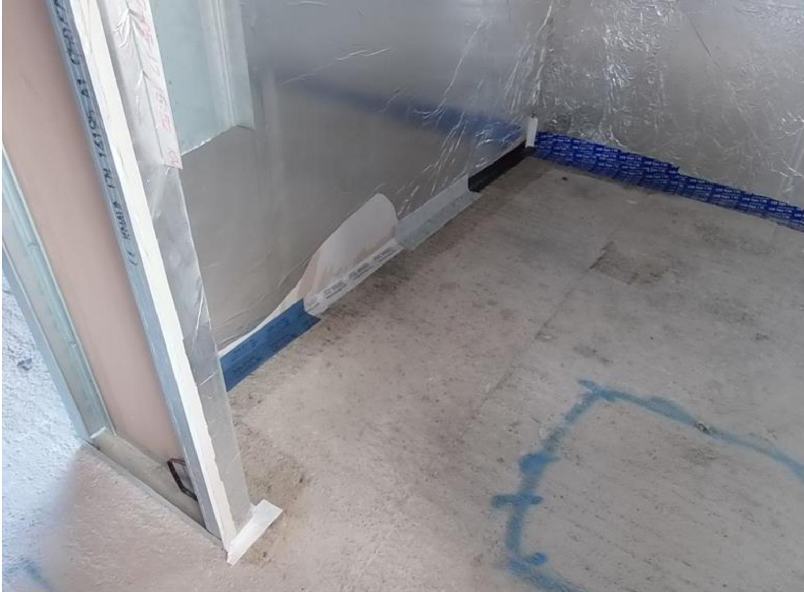
PROVE DI NASTRATURE RIWEGA SU SOLETTA GREZZA DI CAMERA CAMPIONE PRIMA DELLA REALIZZAZIONE DELLE PAREI A TENUTA ALL'ARIA
