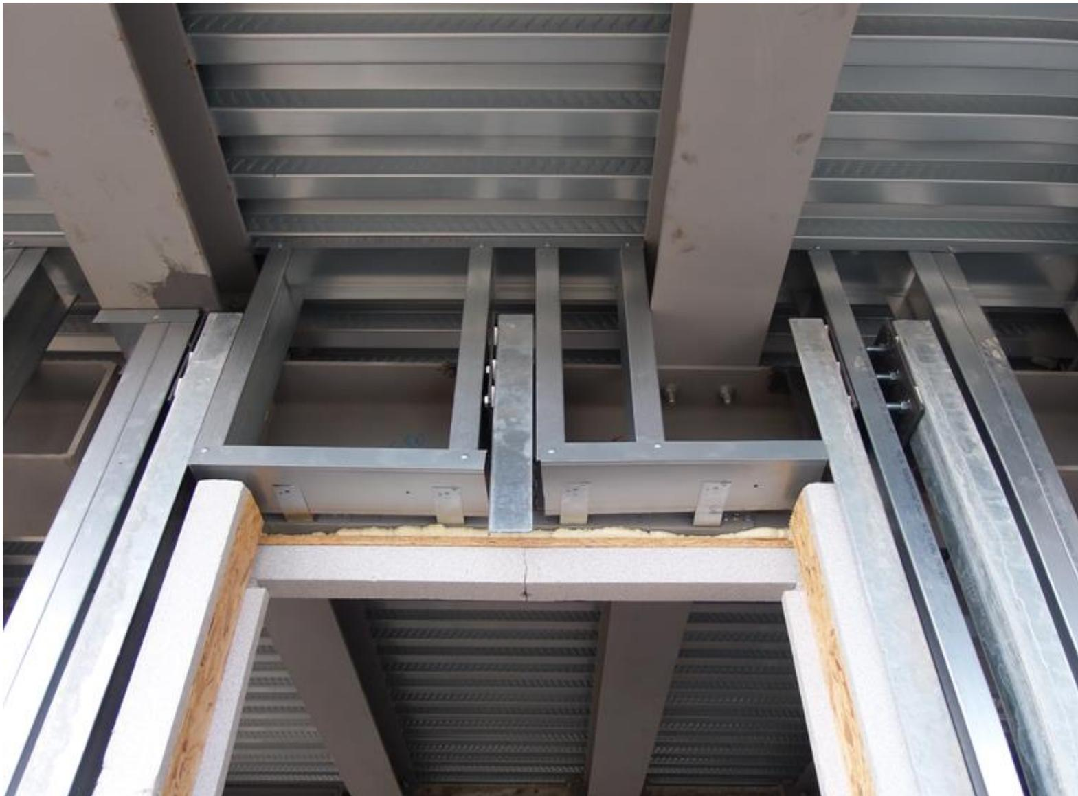
**PARTICOLARE STRUTTURA PER SISTEMA E SECCO SOPRA IMBOTTE FINESTRA E STRUTTURA METALLICA CON DISGIUNTORI TERMICI (COLOR BIANCO) PER IL FISSAGGIO DELLA SOTTOSTRUTTURA IN ALLUMINIO PER FACCIATA VENTILATA IN PANNELLI DI GRC DI FINITURA**
