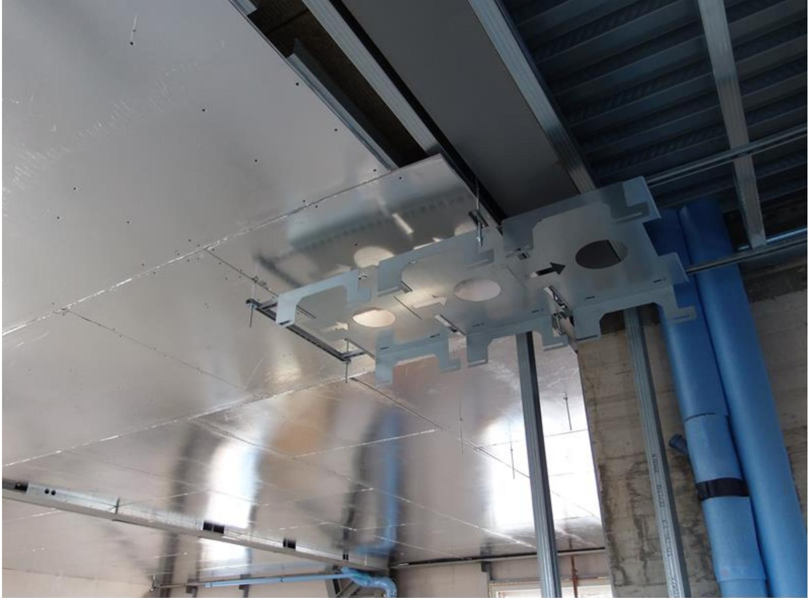
POSA DI PANNELLI CONTROSOFFITTO CHE POI ANDRANNO NASTRATI NELLE GIUNTE E REALIZZAZIONE DI TELAIO DI SOSTEGNO MACCHINA VMC
