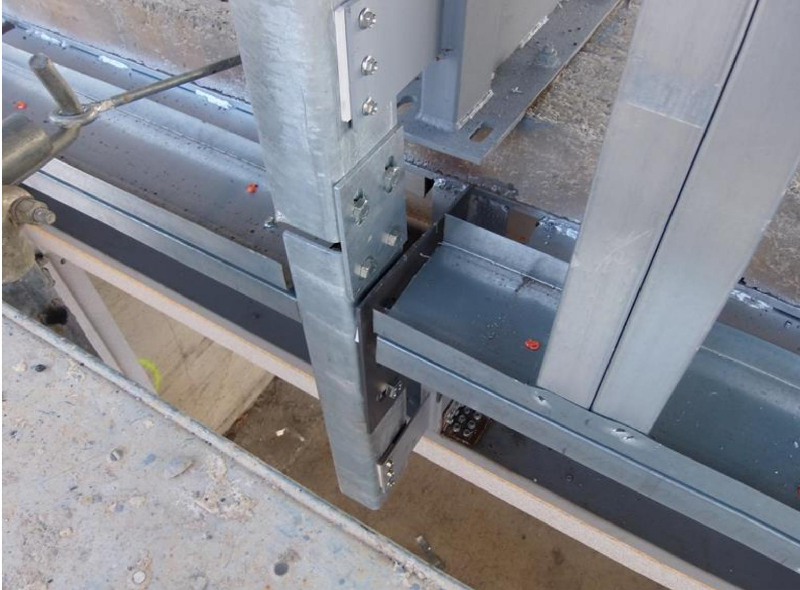
**PARTICOLARE SOTTOSTRUTTURA METALICA IMBULLONATA ALLE PIASTRE DI ANCORAGGIO FISSATE ALLA STRUTTURA PORTANTE CON DISGIUNTORE TERMICO (DI COLORE BIANCO)**
