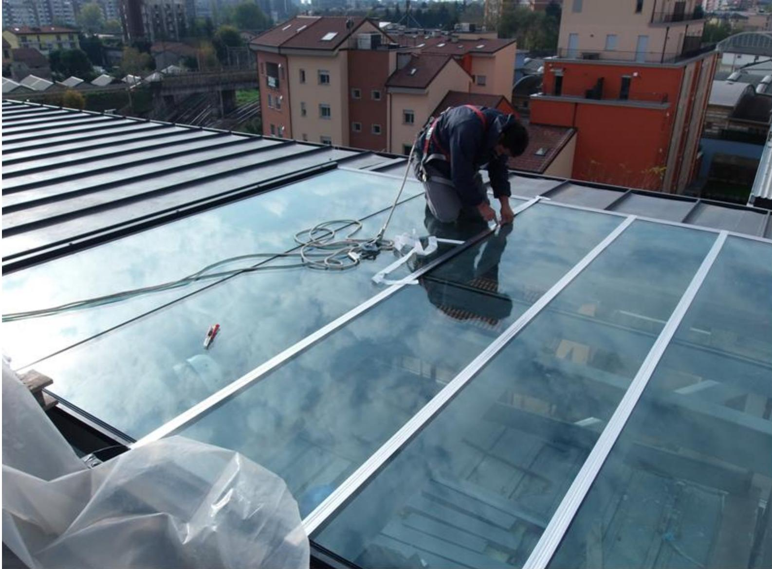
**POSA DI COPERTURA VETRATA PIANA CALPESTABILE IN CORRISPONDENZA DELLA SERRA BIOCLIMATICA DEL VANO SCALE E ASCENSORE**
