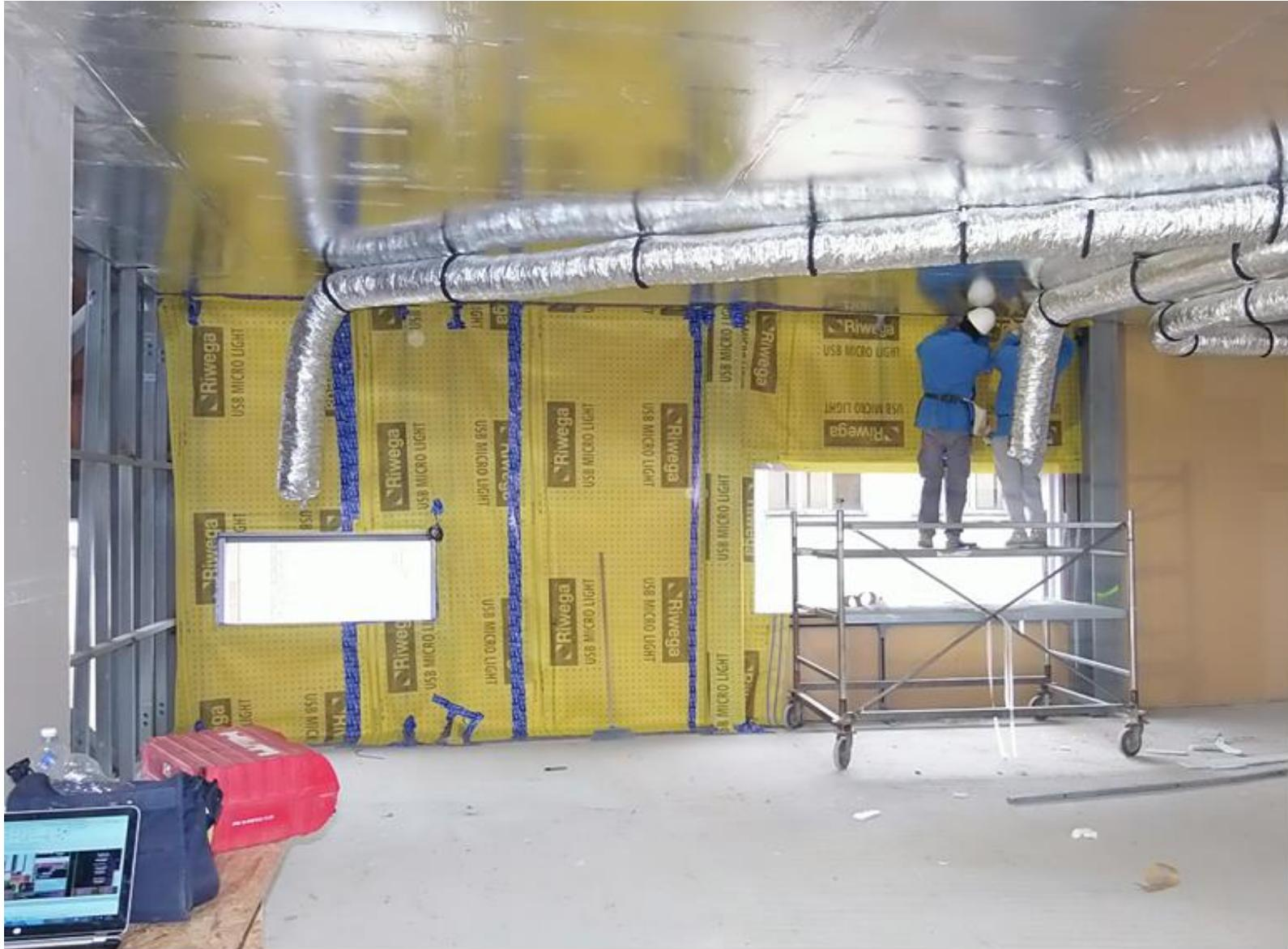
POSA DI TELO DI TENUTA ALL'ARIA RIWEGA SOPRA LO STRATO ISOLANTE IN FIBRA DI LEGNO CON RELATIVA NASTRATURE BLU DI TENUTA ALL'ARIA
