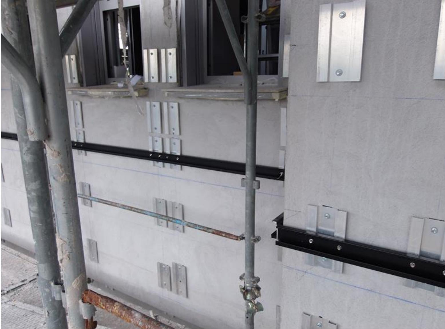
**MONTAGGIO STAFFE A OMEGA PER FACCIATA VENTILATA DIRETTAMENTE FISSATE ALLA SOTTOSTRUTTURA METALLICA IN FERRO ZINCATO CON VITI
