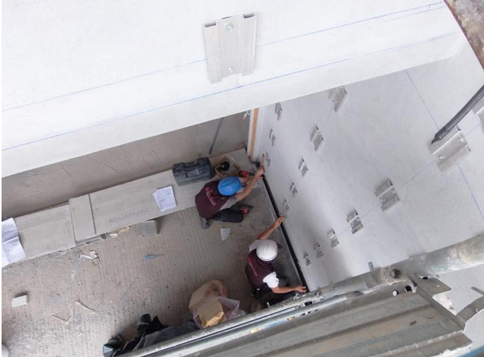
**MONTAGGIO DI STAFFE A OMEGA PER FACCIATA VENTILATA DIRETTAMENTE FISSATE ALLA SOTTOSTRUTTURA METALLICA IN FERRO ZINCATO CON VITI CON GUARNIZIONI DI TENUTA ALL'ACQUA**
