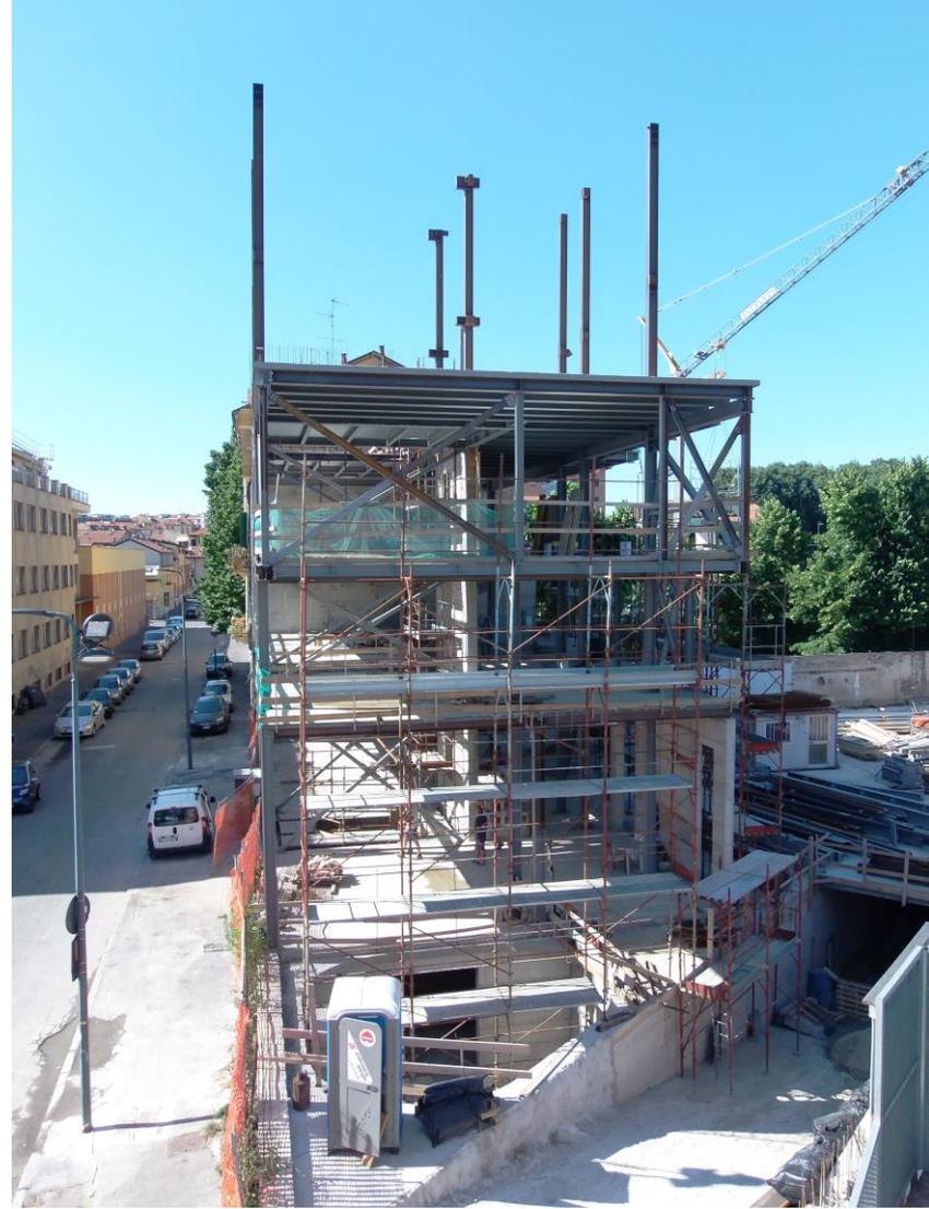
**STRUTTURE IN ACCIAIO PER L'INTERO PIANO INTERRATO ESCLUSA UNA PARTE DEL PIANO INTERRATO IN CORRISPONDENZA DELL'IMPRONTA DELL'EDIFICIO HANNO PERMESSO DI NON AVERE PILASTRI INTERMEDI E DI PROCEDERE RAPIDAMENTE CON I TEMPI DI ESECUZIONE DEI LAVORI**
