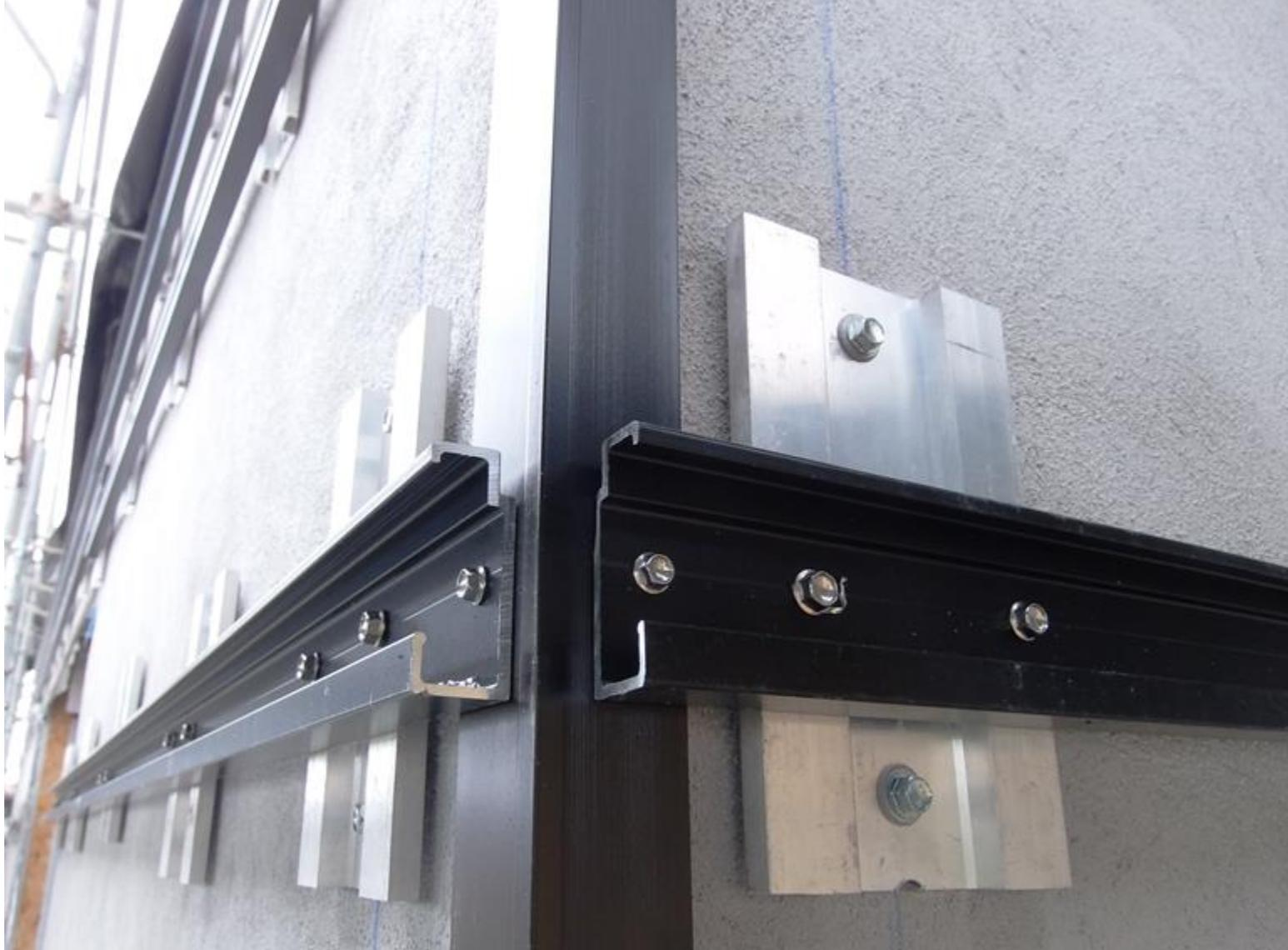
**PARTICOLARE D'ANGOLO MONTAGGIO STAFFE A OMEGA PER FACCIATA VENTILATA DIRETTAMENTE FISSATE ALLA SOTTOSTRUTTURA METALLICA IN FERRO ZINCATO CON VITI CON GUARNIZIONI DI TENUTA ALL'ACQUA**
