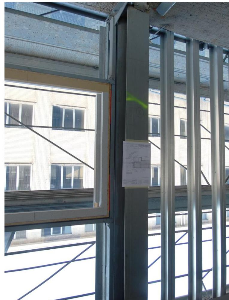
**PARTICOLARE IMBOTTE ISOLATO IN CORRISPONDENZA DI UN PILASTRI SULLA SINISTRA E SOTRUTTURA PORTANTE KNAUF PER PRIMO LIVELLO DI PARETE STRATIFICATA A SECCO SULLA DESTRA**
