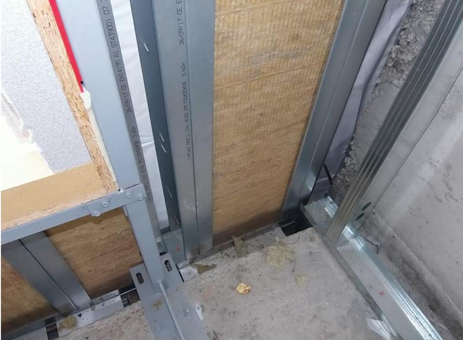
**PARTICOLARE STRUTTURA A SECCO Davanti alla soletta interpiano che costituisce un isolamento continuo della facciata a cappotto di circa 18 centimetri senza interruzione**
