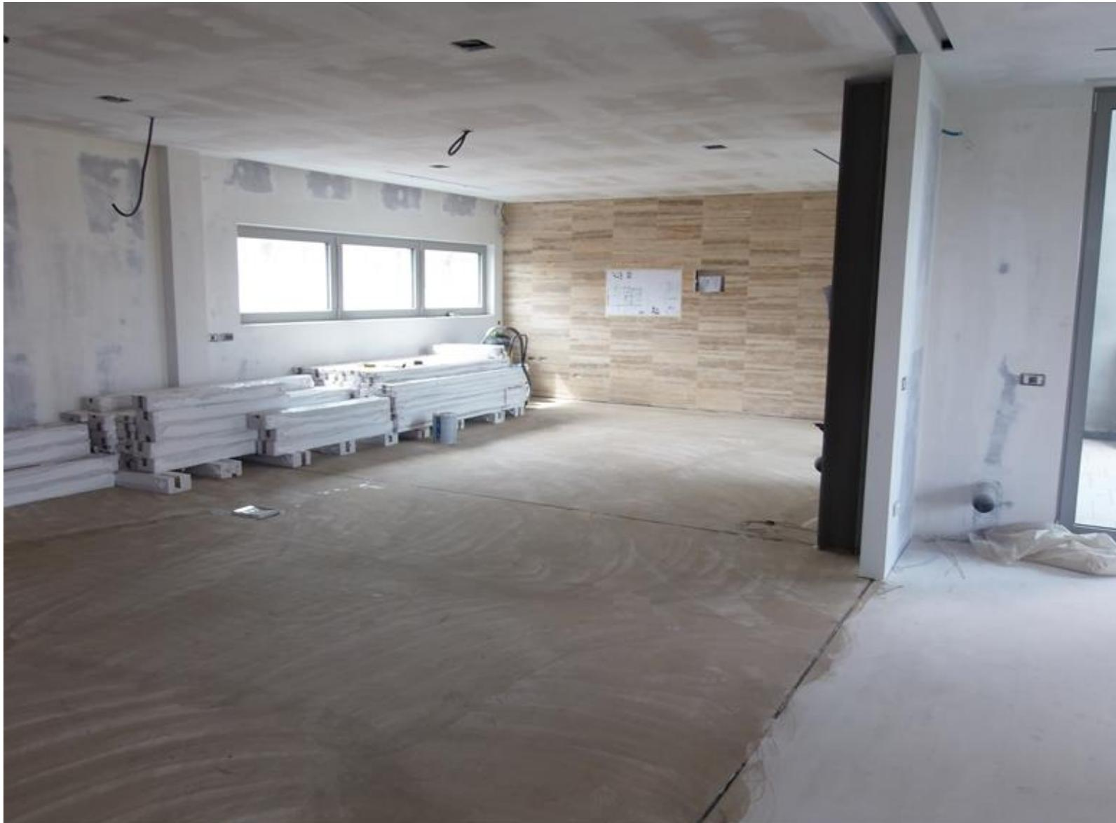
**FINITURA DELLE PARETI A SECCO A LIVELLO Q3 DI KNAUF E TRATTAMENTO CON PRIMER DEL MASSETTO PRIMA DELL'INCOLLAGGIO DEL PAVIMENTO IN LEGNO**
