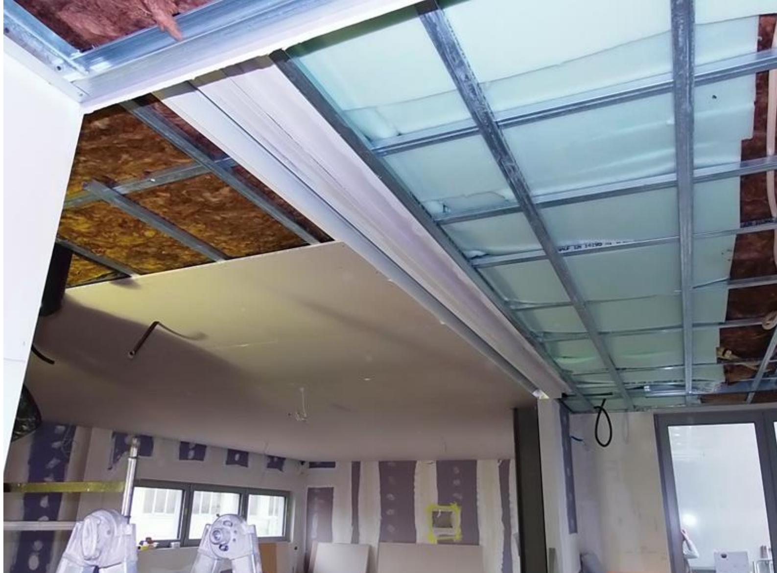
**SECONDO LIVELLO DI ISOLAMENTO CONTROSOFFITTO CON LANA DI ROCCIA E PANNELLI IN POLIESTERE COMPRIMIBILE IN CORRISPONDENZA DELLA RIPRESA DELL'ARIA A CONTROSOFFITTO**
