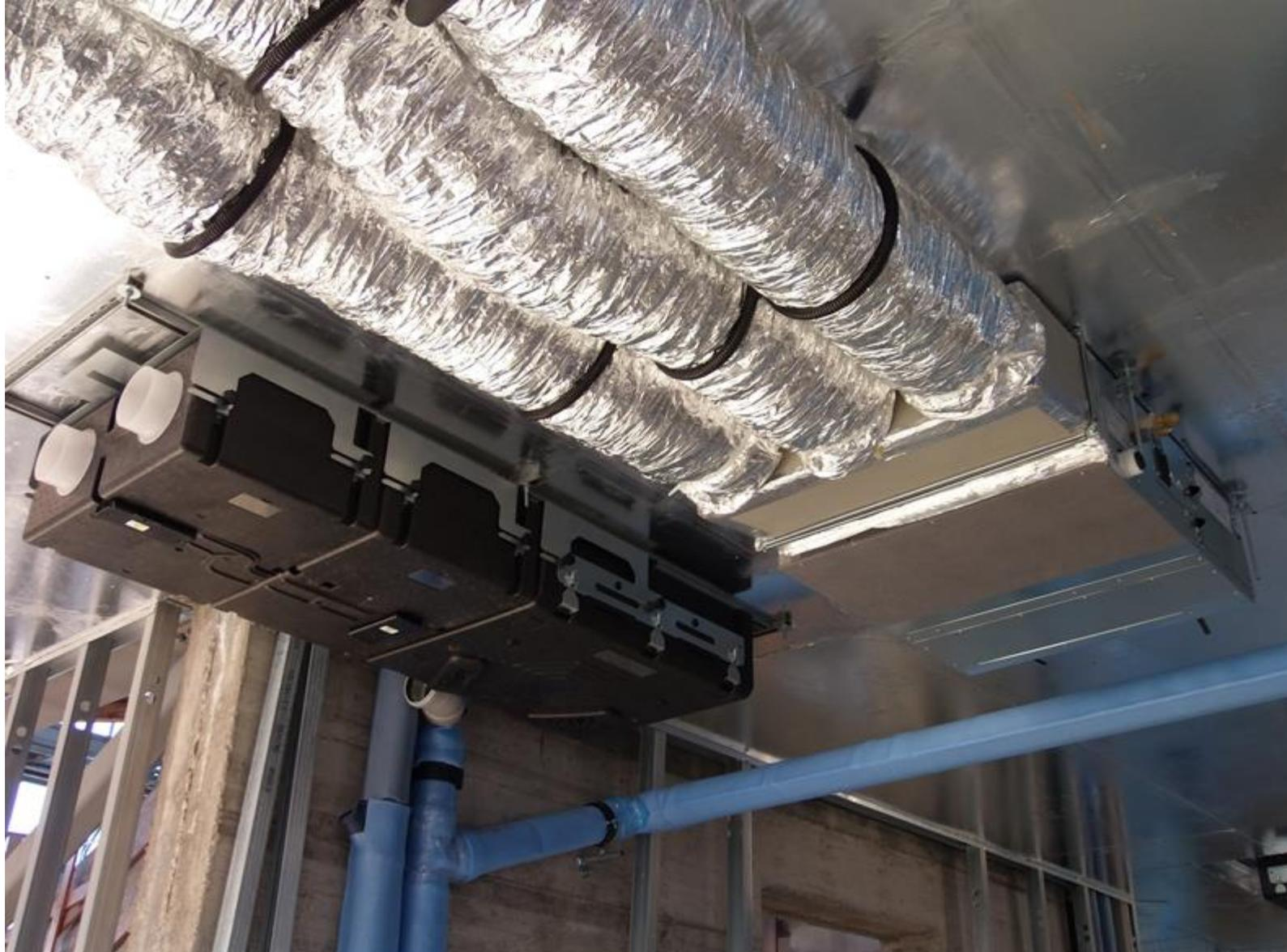
**MONTAGGIO IMPIANTO VRV E VMC A SOFFITTO CON SIGILLATURA FORI PER LA TENUTA ALL'ARIA**
