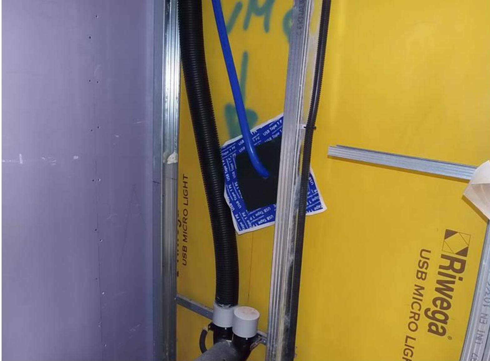
**PARTICOLARE FISSAGGIO BOCCA DI IMMISSIONE ARIA PRIMARIA E SISTEMA DI TENUTA ALL'ARIA RIWEGA PER TUBAZIONE ACQUA CHE ATTRAVERSA LA FACCIATA**
