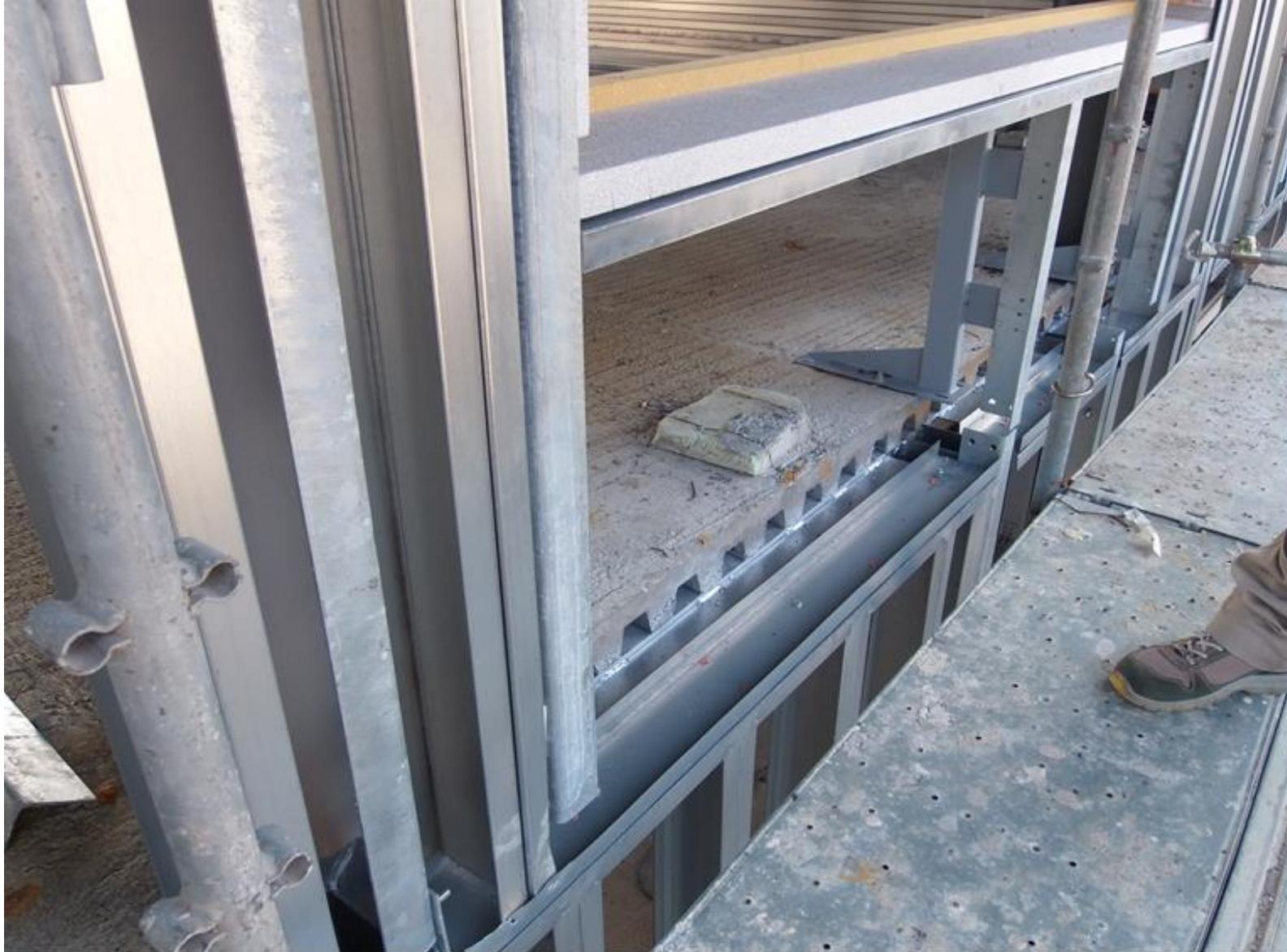
**PARTICOLARE STRUTTURA A SECCO Davanti alla soletta interpianto che costituisce un isolamento continuo a cappotto di 18 centimetri circa della facciata senza interruzione da piano a piano**
