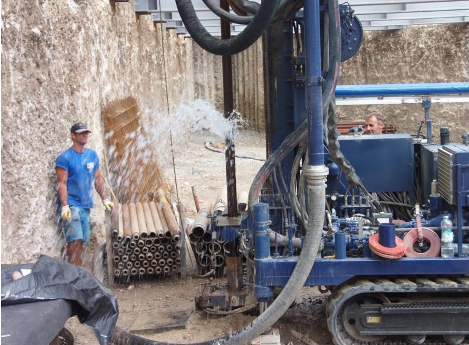
REALIZZAZIONE DI 8 SONDE GEOTERMICHE PROFONDE OLTRE 120 METRI DI WEISHAAPT
