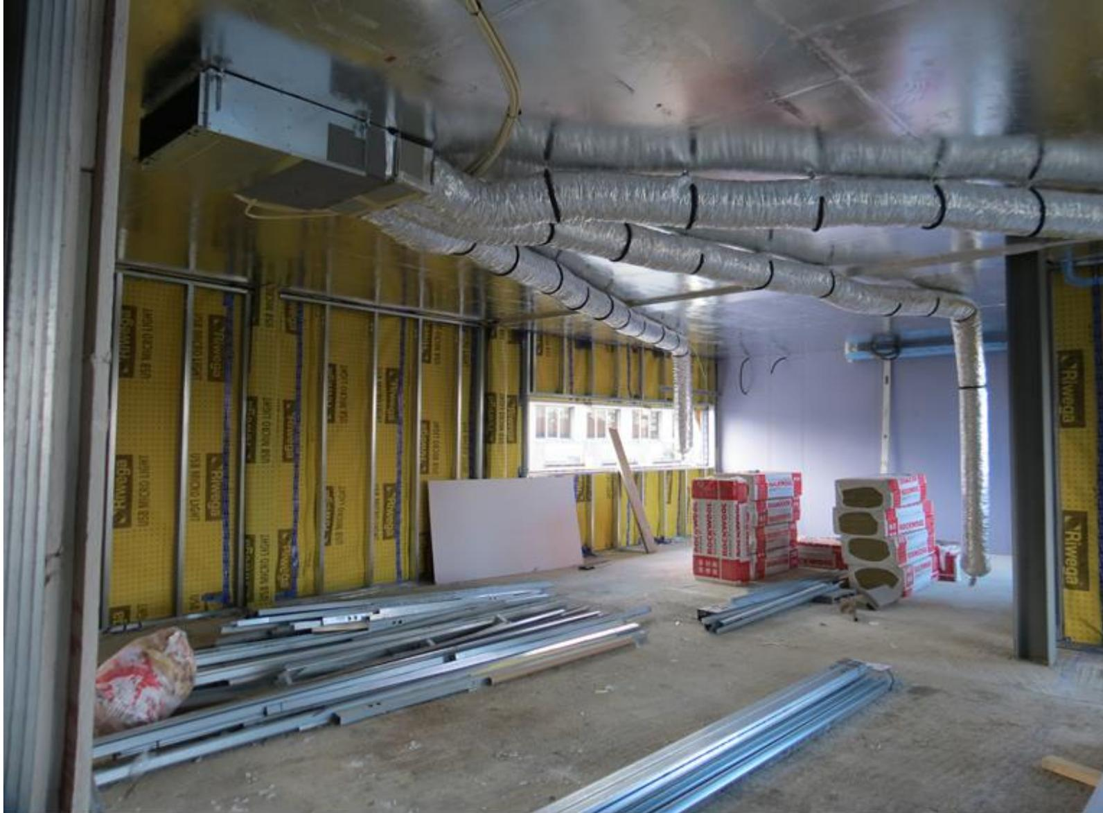
POSA DI TELO A TENUTA ALL'ARIA DI RIWEGA LUNGO TUTTE LE PARETI PERIMETRALI DELL'EDIFICIO PER LE PROVE DI TENUTA ALL'ARIA
