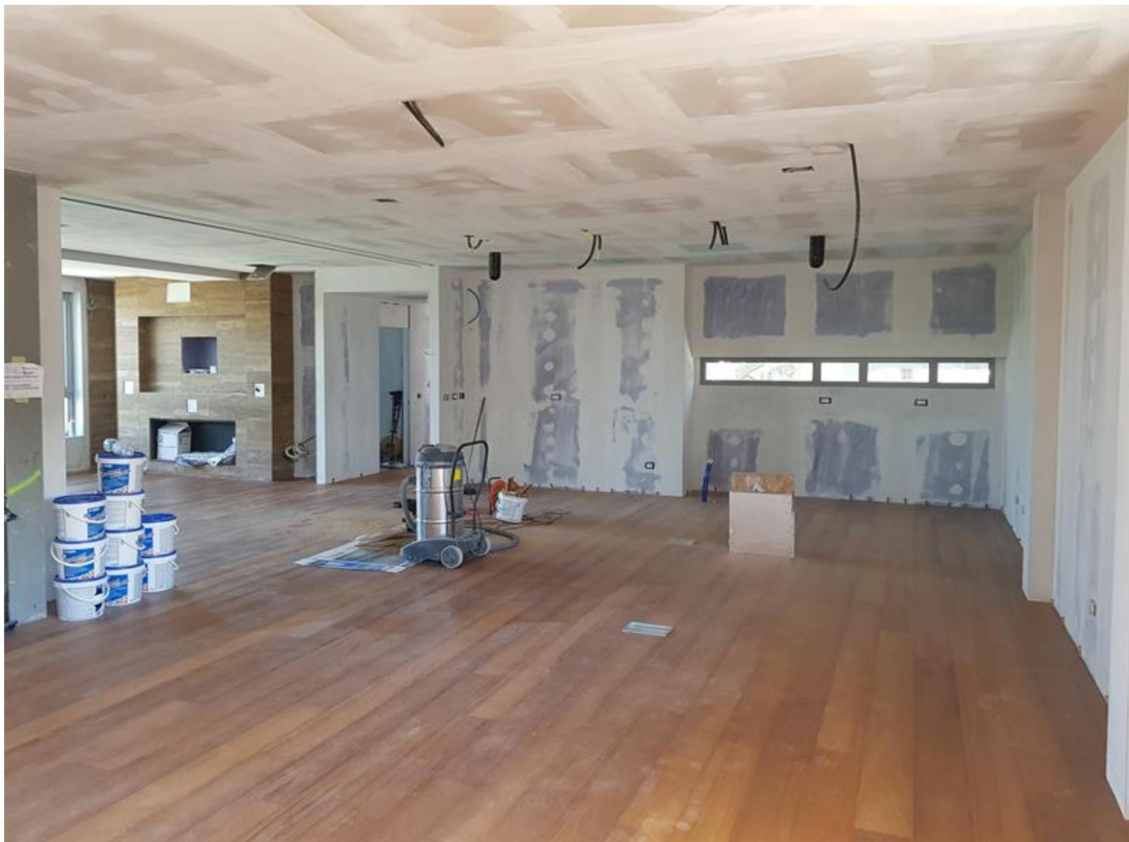
**FINITURA DEL CONTROSOFFITTO PRIMA DELLE TINTEGGIATURE E DELLE PARETI CON FINITURA Q3 DI KNAUF**
