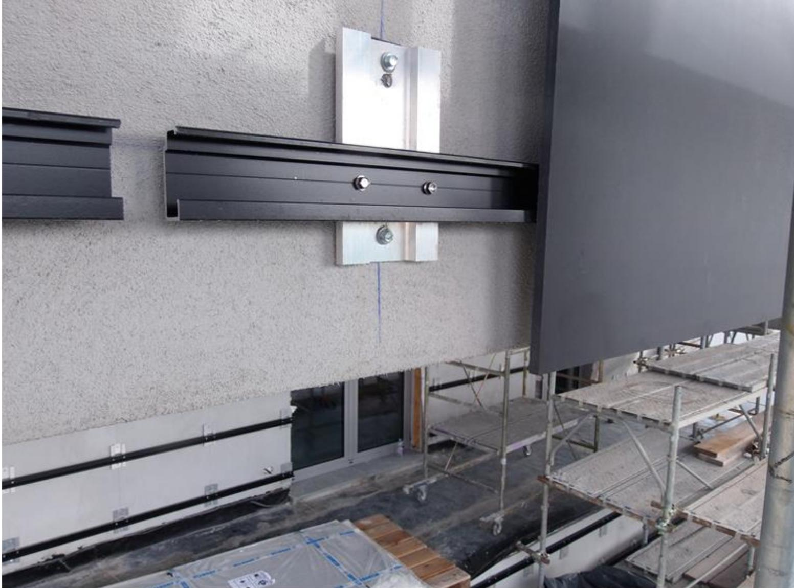
**PARTICOLARE FISSAGGIO PANNELLI IN GRC ALLA STRUTTURA SECONDARIA**
