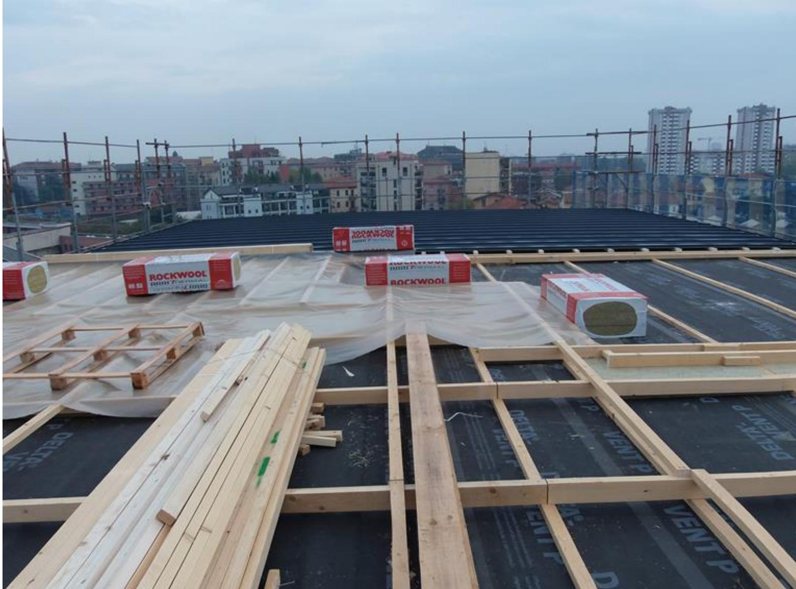
**POSA DELLA COIBENTAZIONE E DELLA LAMIERA DI FINITURA DELLA COPERTURA PIANA VENTILATA AD ALTO GRADO DI ISOLAMENTO ALL'ACQUA TRAMITE UN PARTICOLARE SISTEMA DI FISSAGGIO DEI PANNELLI IN ALLUMINIO PREVERNICIATO**
