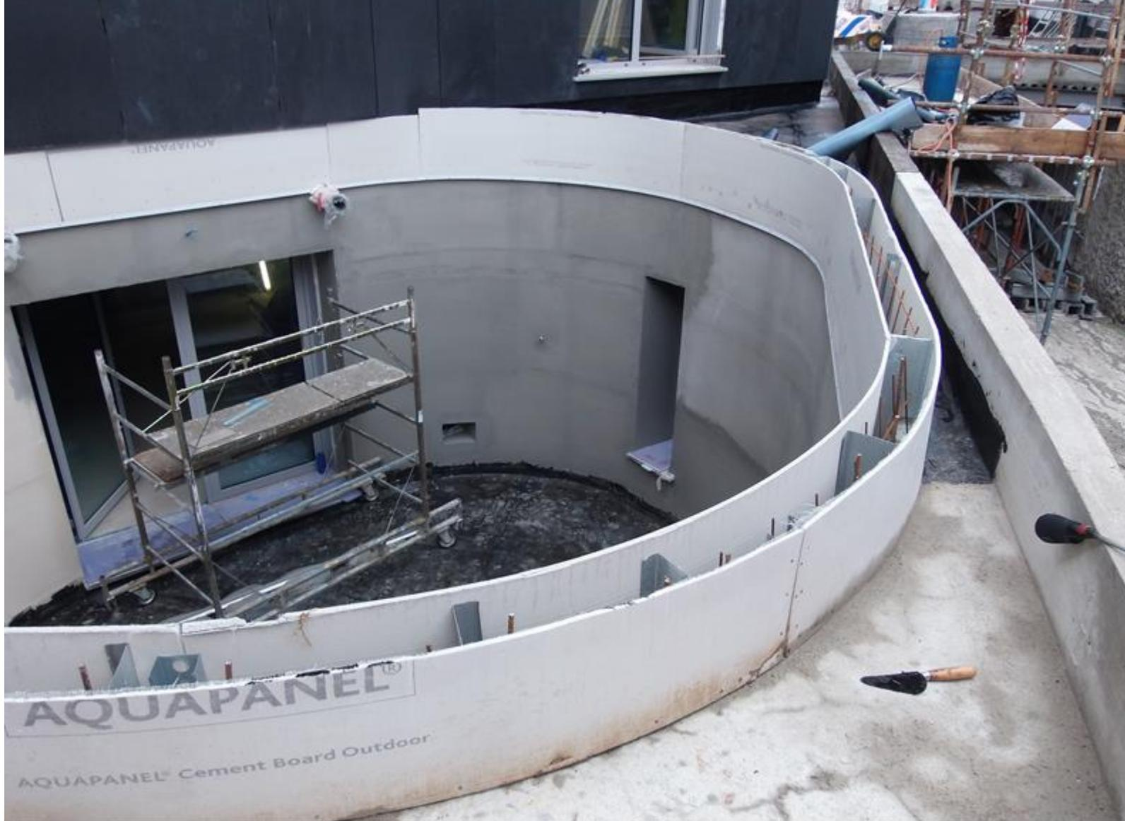
ELEMENTI IN AQUAPANEL CURVATO CON FUNZIONE DI CASSERO A PERDERE PER REALIZZAZIONE DI CORDOLO IN C.A.
