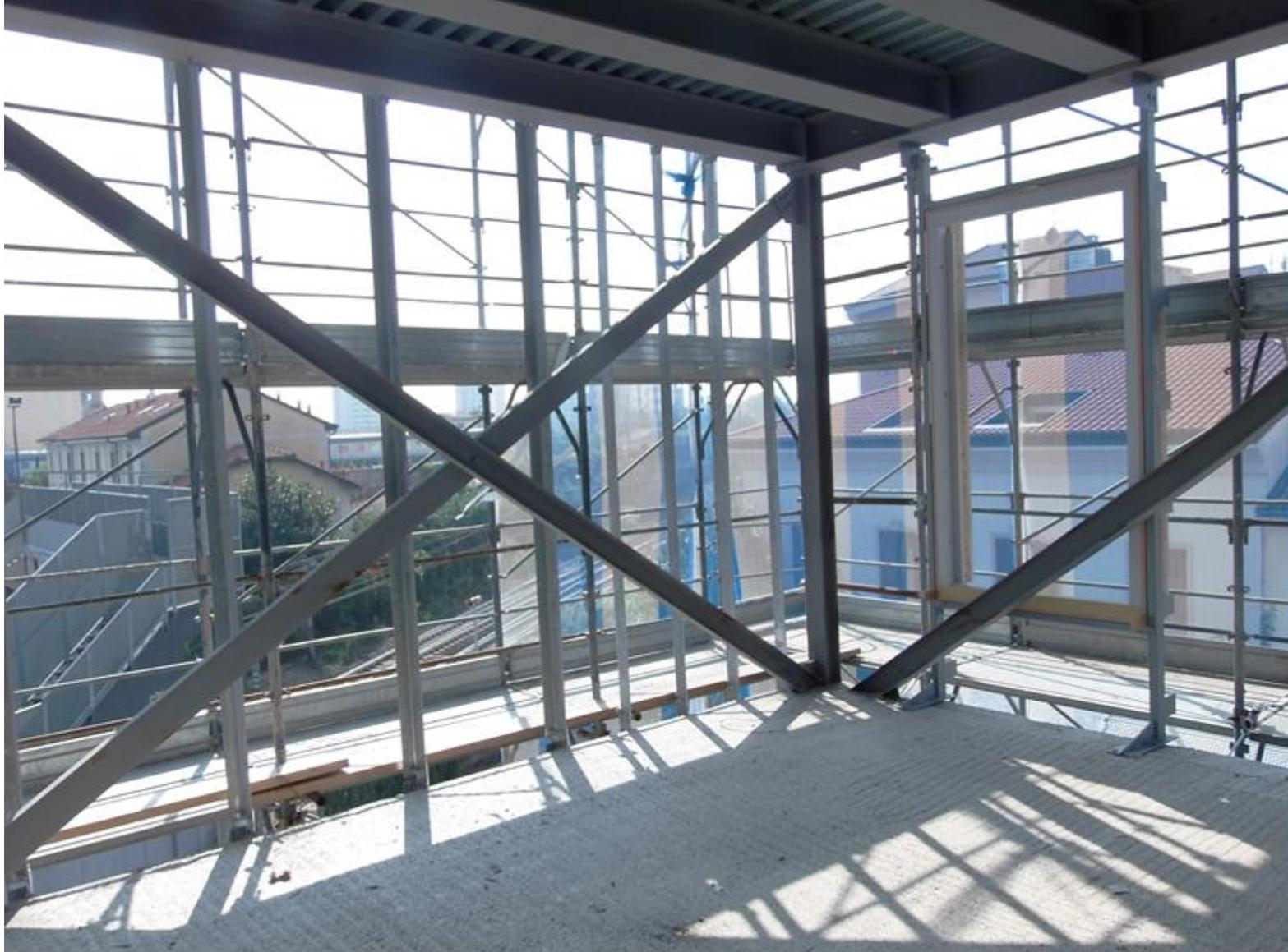
**SOTTOSTRUTTURA SECONDARIA IN ACCIAIO PER IL SOSTEGNO DELLA FACCIATA VENTILATA IN PANNELLI DI GRC E IMBOTTI ISOLATI DI HELLA FISSATI A TELAI METALLICI IN FERRO**
