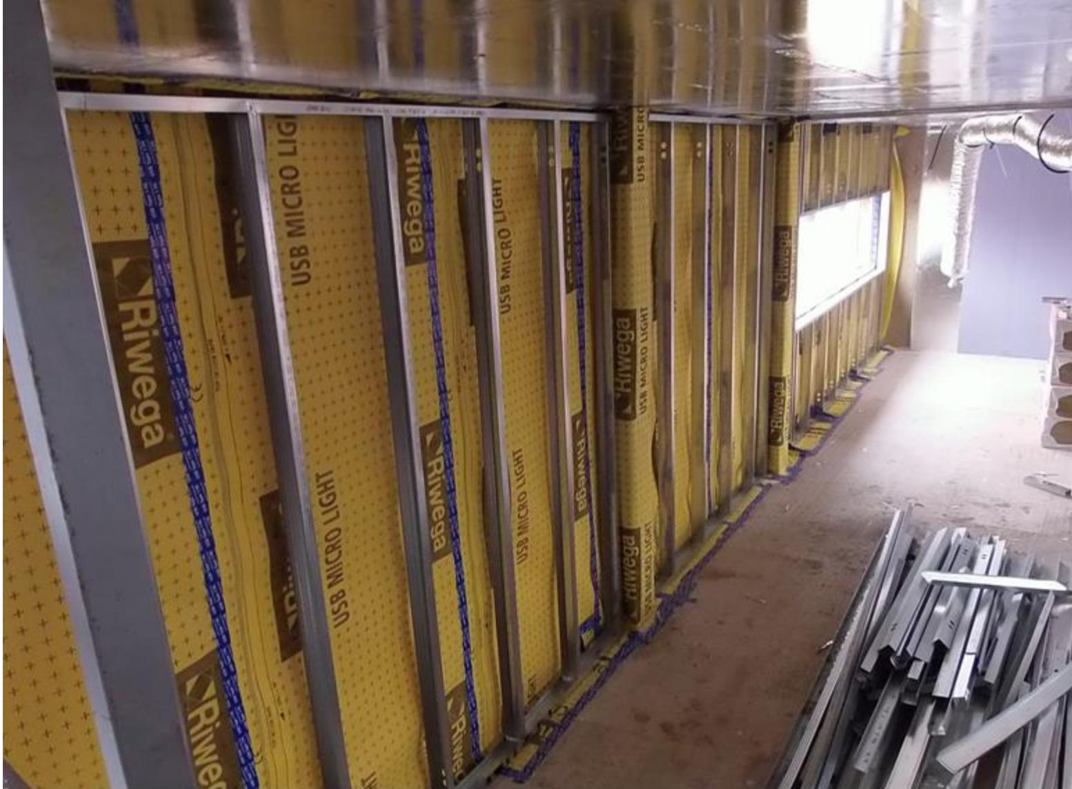
**NASTRATURE TRA TELI VETRICALI E SOFFITTO E A TERRA A TENUTA ALL'ARIA DAVANTI A CUI È POSTA LA STRUTTURA DELLA PARETE DI FINITURA INTERNA DELL'INVOLUCRO A SECCO COMPLETA DI ISOLAMENTO IN LANA DI ROCCIA**
