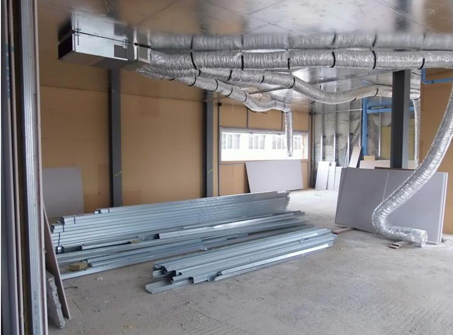
POSA DI PANNELLI IN FIBRA DI LEGNO DAVANTI AL PANNELLI IN CARTOGESSO KNAUF GKB E VISIONE DELLA POSA DELL'IMPIANTO VRV A SOFFITTO
