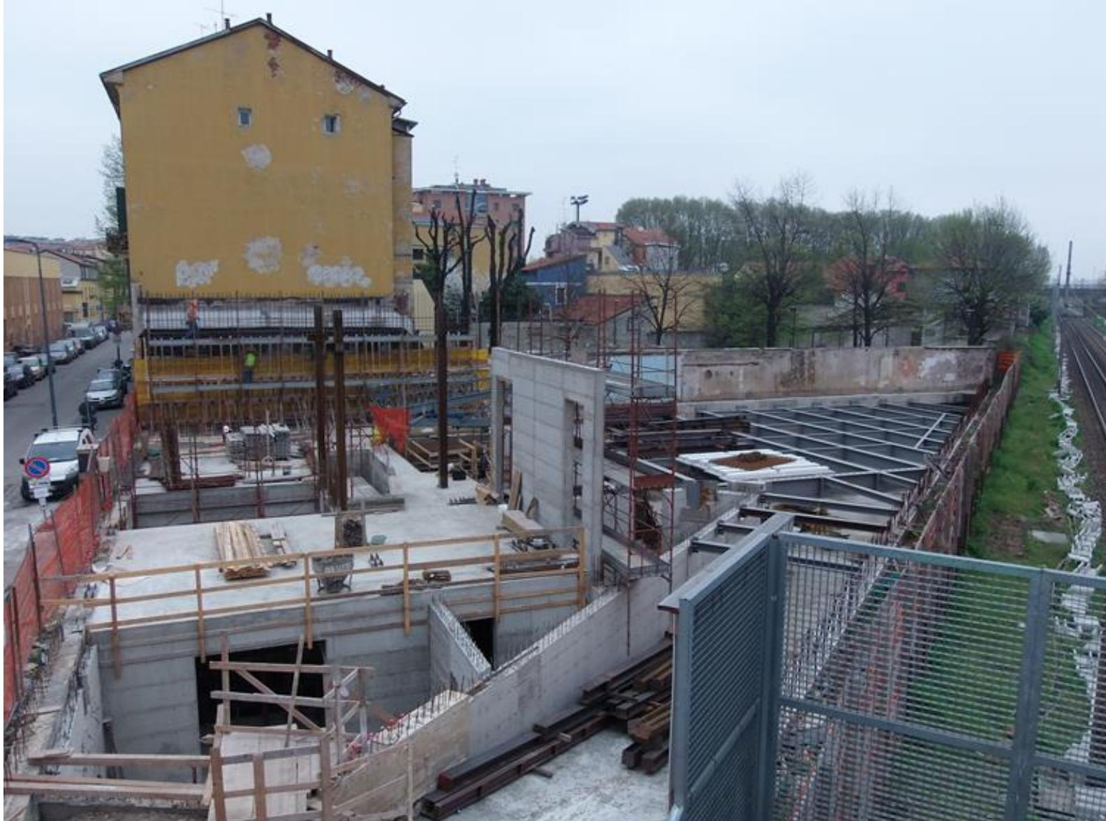
**STRUTTURE IN ACCIAIO PER L'INTERO PIANO INTERRATO ESCLUSA UNA PARTE DEL PIANO INTERRATO IN CORRISPONDENZA DELL'IMPRONTA DELL'EDIFICIO HANNO PERMESSO DI NON AVERE PILASTRI INTERMEDI E DI PROCEDERE RAPIDAMENTE CON I TEMPI DI ESECUZIONE DEI LAVORI**
