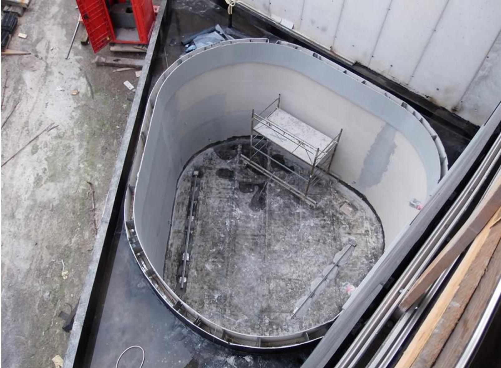
ELEMENTI IN AQUAPANEL CON FUNZIONE DI CASSERO A PERDERE PER REALIZZAZIONE DI CORDOLO CURVO IN C.A.
