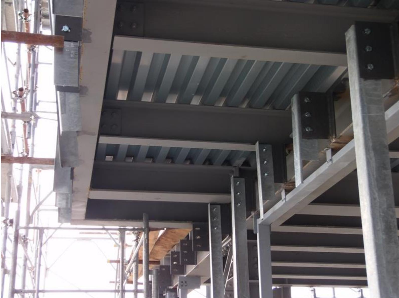
**PARTICOLARE SOTTOSTRUTTURA METALICA IMBULLONATA ALLE PIASTRE DI ANCORAGGIO FISSATE ALLA STRUTTURA PORTANTE**
