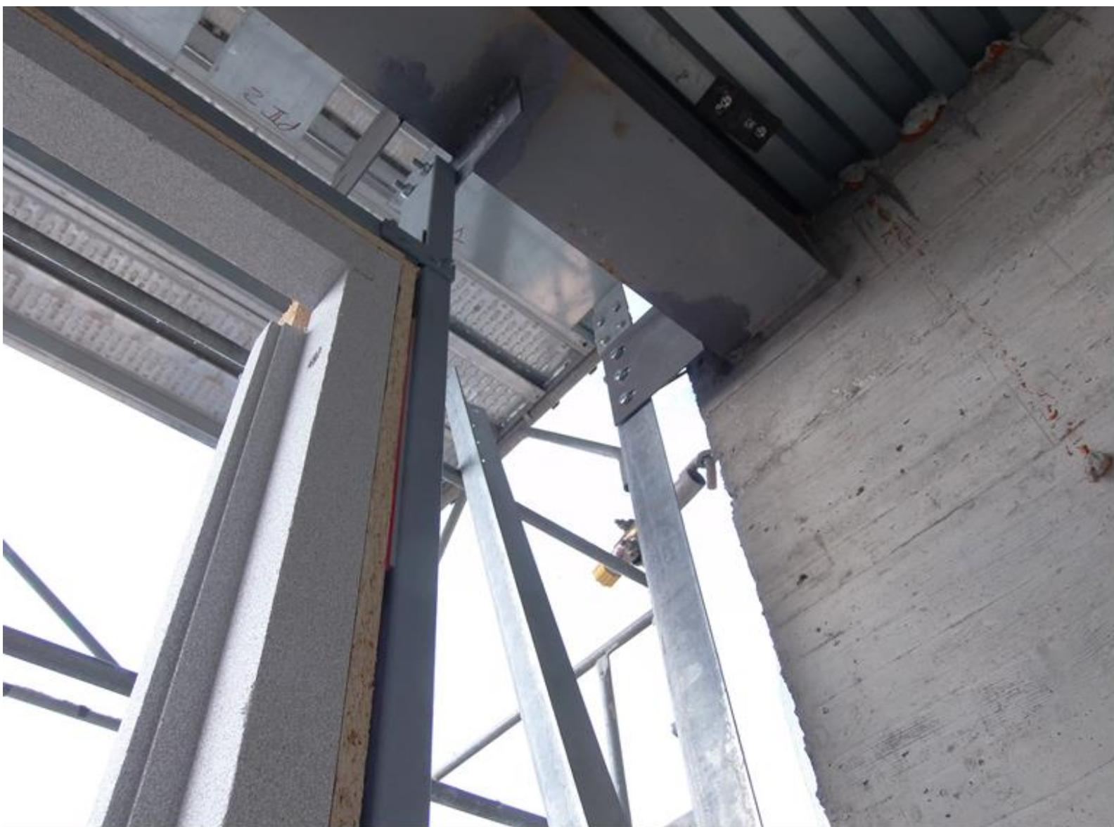
**DETTAGLIO IMBOTTE ISOLATO DI HELLA E ANCORAGGIO DI MONTANTI IN FERRO ZINCATO PER FISSAGGIO STRUTTURA SECONDARIA DI SOSTEGNO DEI PANNELLI DI FACCIATA DI FINITURA IN GRC**
