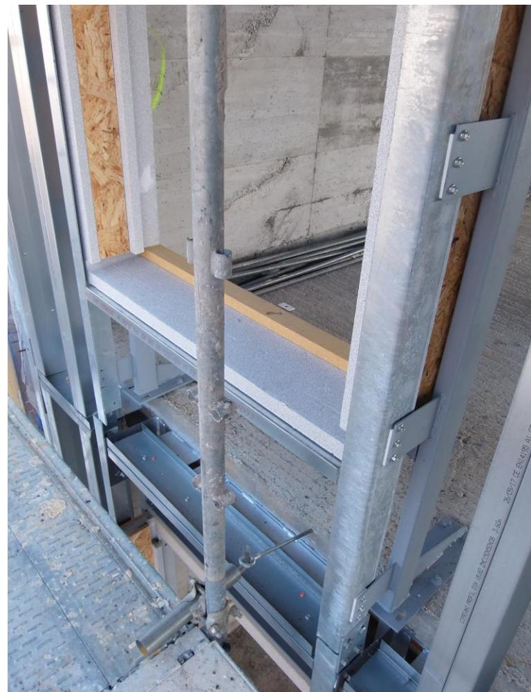
**PARTICOLRE IMBOTTE ISOLATO DI HELLA ED INTERFERENZA DELLA STRUTTURA A SECCO CON LA STRUTTURA AGGETTANTE DALLA SOLETTA INTERPIANO PER PRIMO STRATO ISOLANTE**
