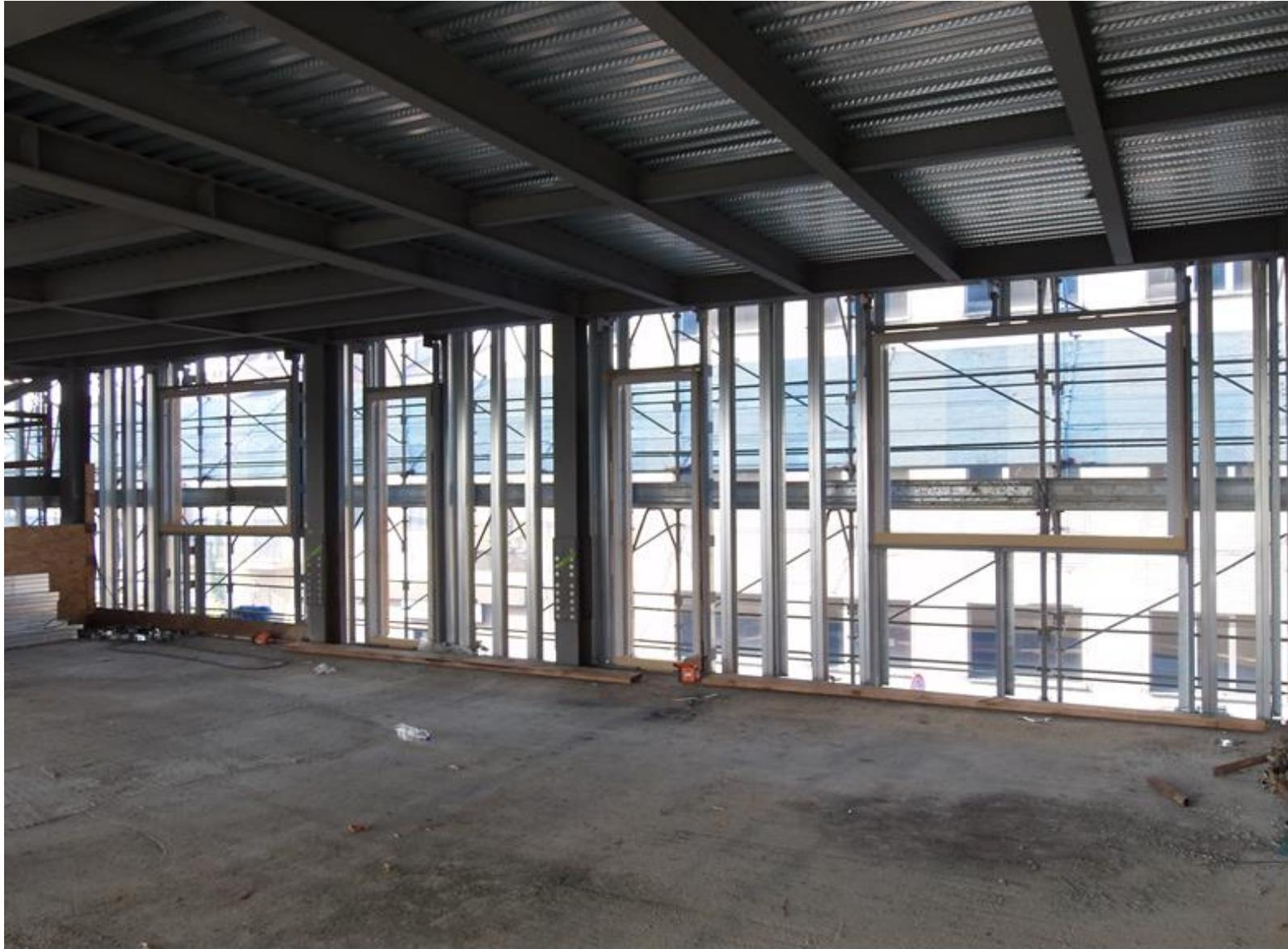
**TELAJ IN FERRO DI SOSTEGNO DEGLI IMBOTTI ISOLATI DI HELLA CHE SONO STATI REALIZZATI PRIMA DELLE PARETI PERIMETRALI E STRUTTURA MONTANTI VERTICALI KNAUF DEL PRIMO LIVELLO DI PARETE STRATIFICATA A SECCO**
