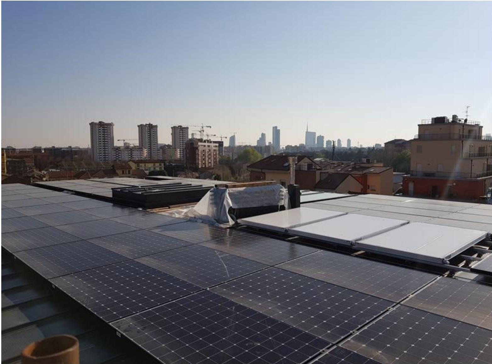
**PANNELLI SOLARI FOTOVOLTAICI E TERMICI SU TUTTA LA COPERTURA PER UN'A SUPERFICIE DI CIRCA 320 MQ. CHE SI INTEGRANO CON LA PRESENZA DELLA LINEA VITA**
