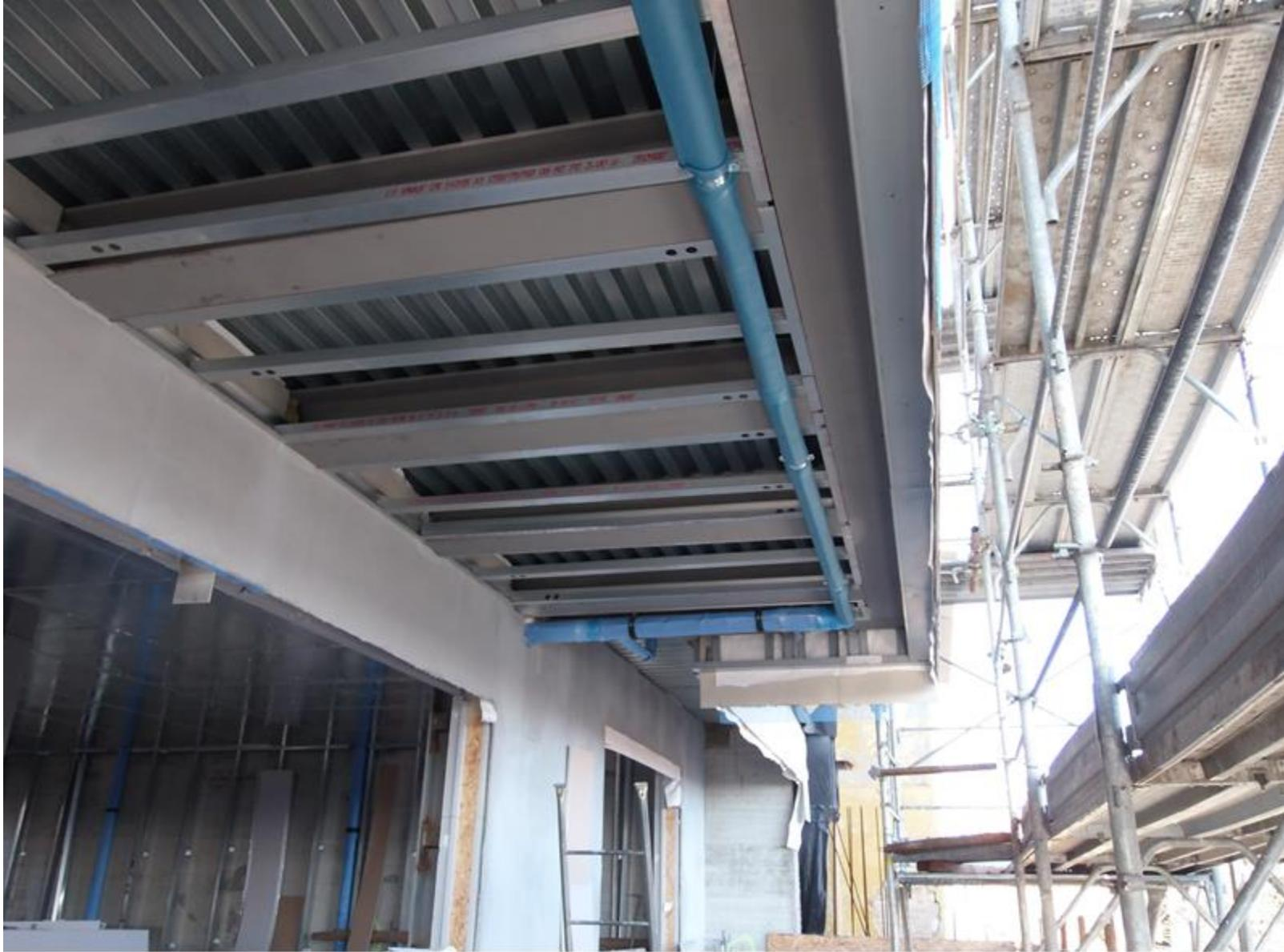
TUBAZIONI DI SCARICO DEI TERRAZZI DEL PIANO SUPERIORE A SOFFITO A TUTTI I PIANI E STRUTTURA PRIMO LIVELLO CONTROSOFFITTO ISOLATO
