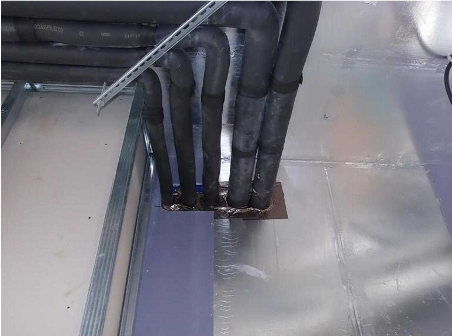
**PARTICOLARE SIGILLATURA CON SISTEMI RIWEGA DELLE TUBAZIONI DELL'IMPIANTO MECCANICO SU PARETE PERIMETRALE VERSO IL VANO SCALE A TUTTI I PIANI**
